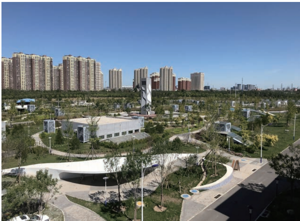
碧水源北京市门头沟区第二再生水厂项目
