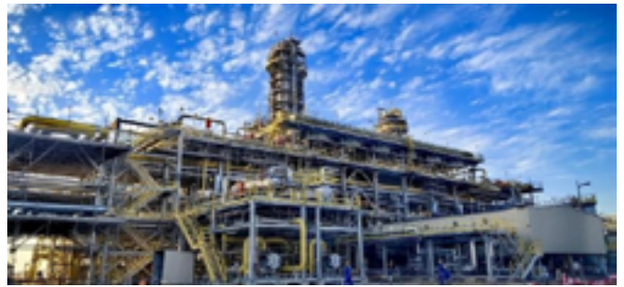
图 1 伊拉克九区油气中央处理设施项目实景
